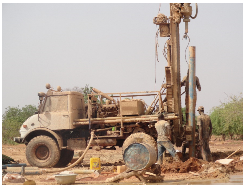
Réalisation du forage de Mosvénogo en 2018
