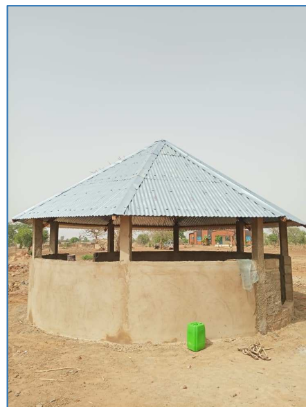
Réalisation du hangar
