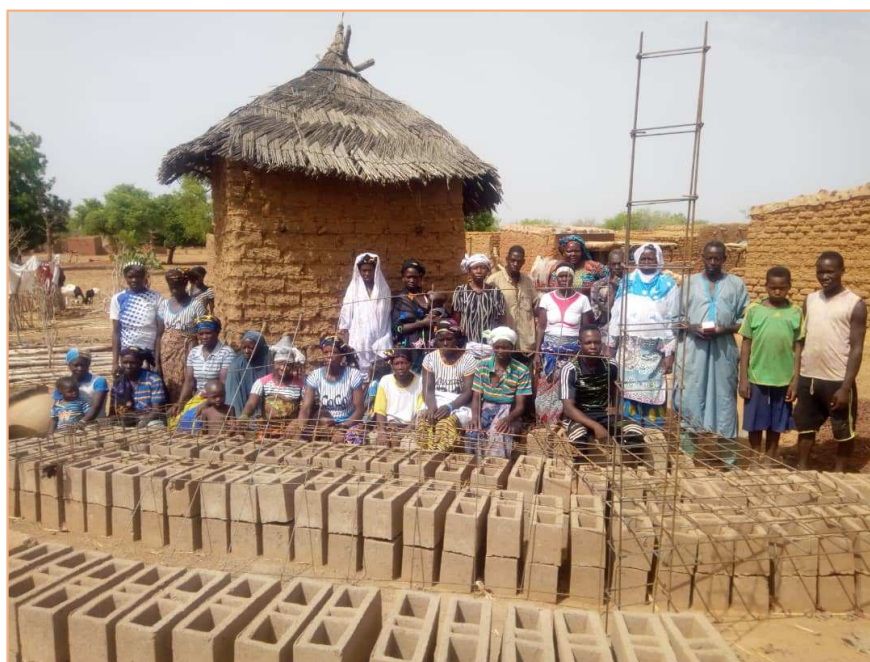
Réalisation des latrines: un bel exemple de participation villageoise...
